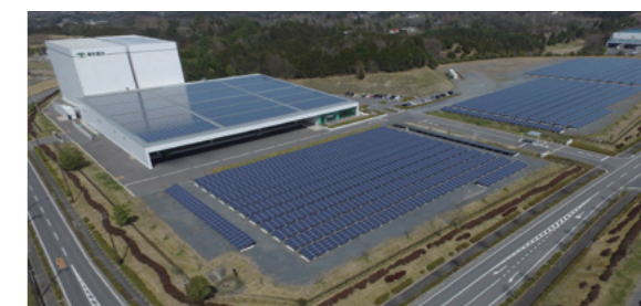
西日本物流センターの太陽光発電設備
