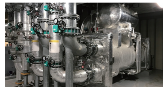
ダブルバンドル式ターボ冷凍機
