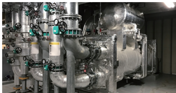
ダブルバンドル式ターボ冷凍機
