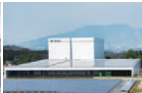
西日本物流センター (右の建物が増築した自動倉庫)
