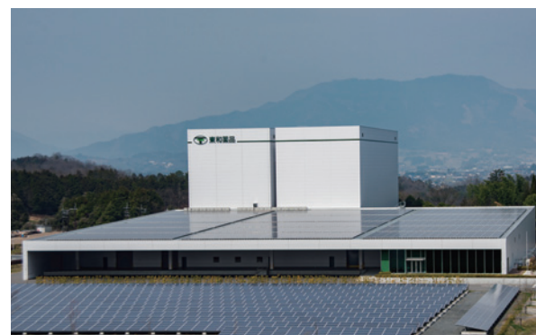
西日本物流センターに設置しているメガソーラー
